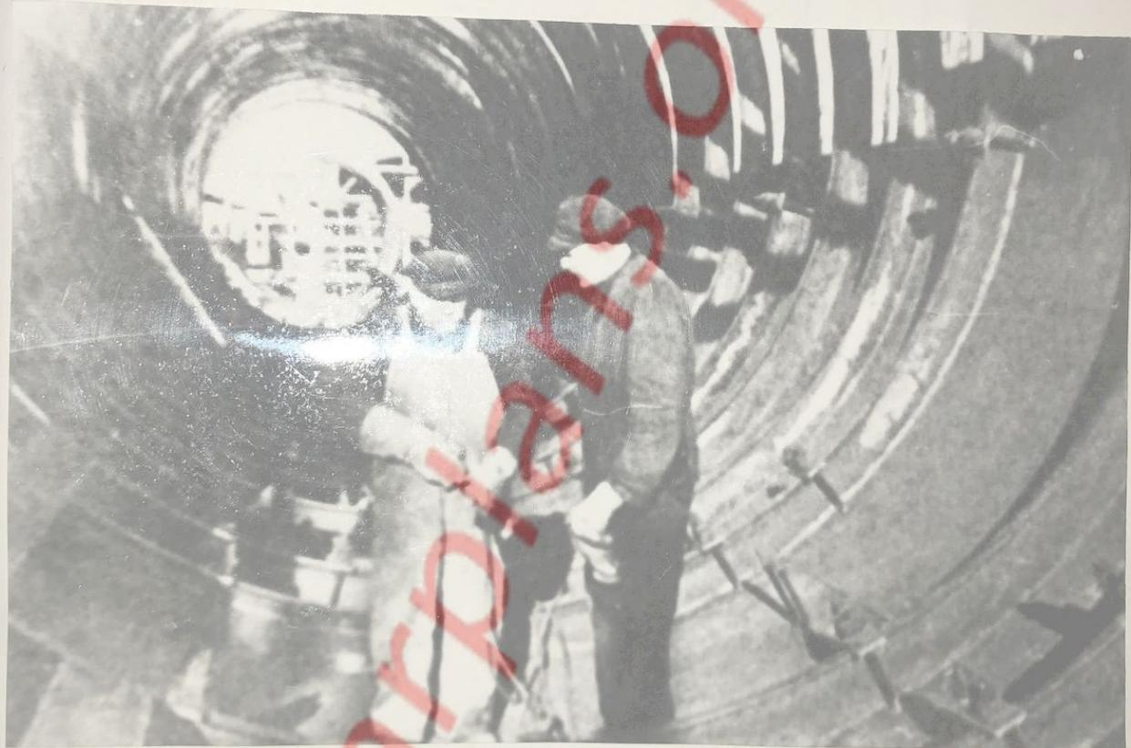
Рис.9. Сборка прочного корпуса подводной лодки секционным методом.
